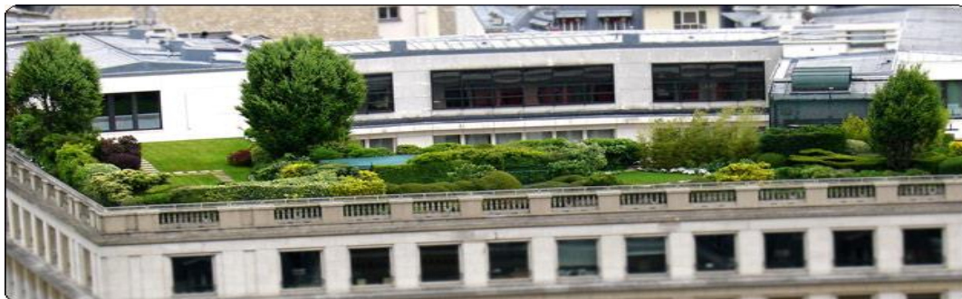
Рис. 2. Пример озеленения кровли
