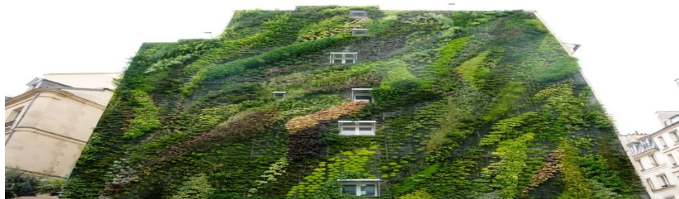
Рис. 1. Пример зеленого фасада
